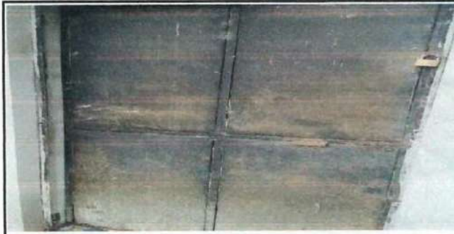
Foto 6: Sustitucion de puerta de metal.
