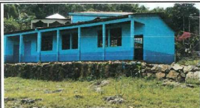
Foto 1: Preservacion de muro de contencion.
