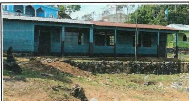
Foto 3: Colocacion del entechado del corredor del establecimiento.
