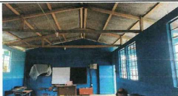
Foto 5: Sustitucion de la estructura de techo.
