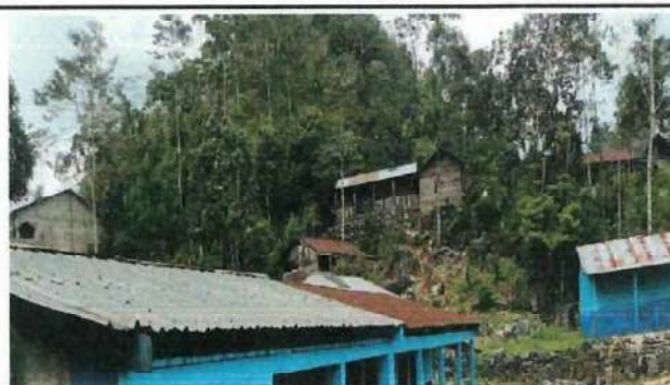
Foto 4: Sustitucion de cubierto de lamina.
