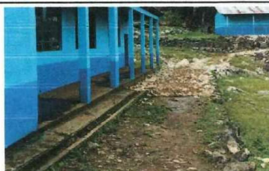
Foto 2: Sustitucion de piso de concreto.
